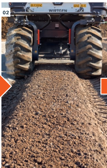
01 – 03 В процессе стабилизации недостаточно прочный грунт превращается в пригодное для строительства, уплотненное основание.
