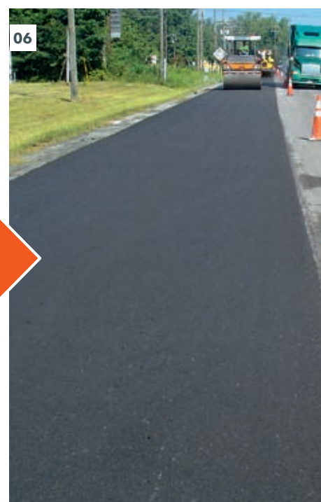
04 – 06 Холодный ресайклинг предусматривает измельчение (гранулирование) поврежденных слоев асфальтового покрытия, внесение в полученную смесь вяжущего, перемешивание и уплотнение смеси и ее последующую укладку.
