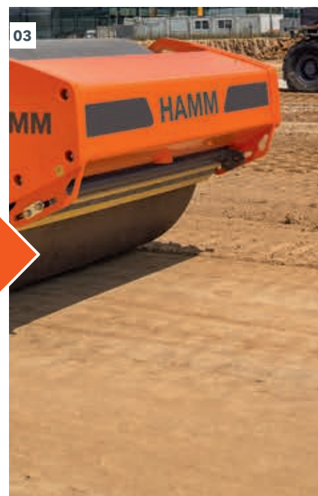
01 – 03 В процессе стабилизации недостаточно прочный грунт превращается в пригодное для строительства, уплотненное основание.
