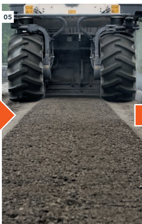
04 – 06 Холодный ресайклинг предусматривает измельчение (гранулирование) поврежденных слоев асфальтового покрытия, внесение в полученную смесь вяжущего, перемешивание и уплотнение смеси и ее последующую укладку.
